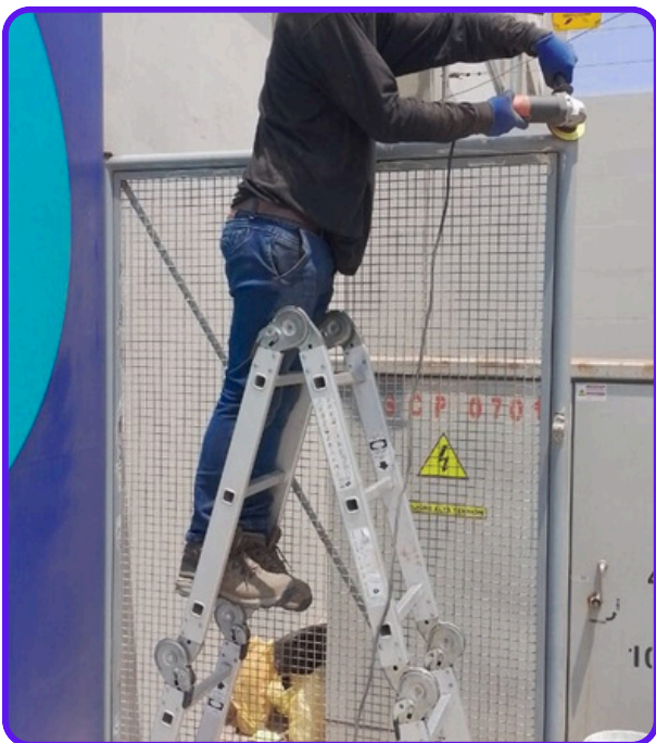
Mantenimiento de Rejas Metálicas
