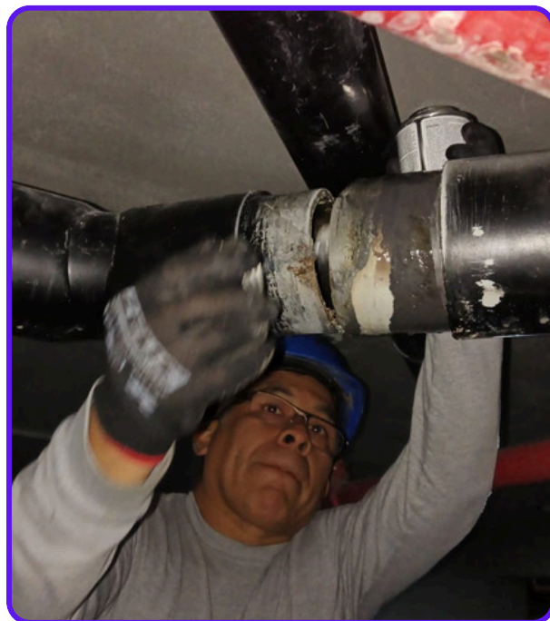
Reparación de Tubería de Desagüe
