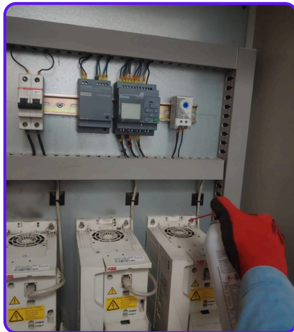
Mantenimiento de Variadores de Velocidad
