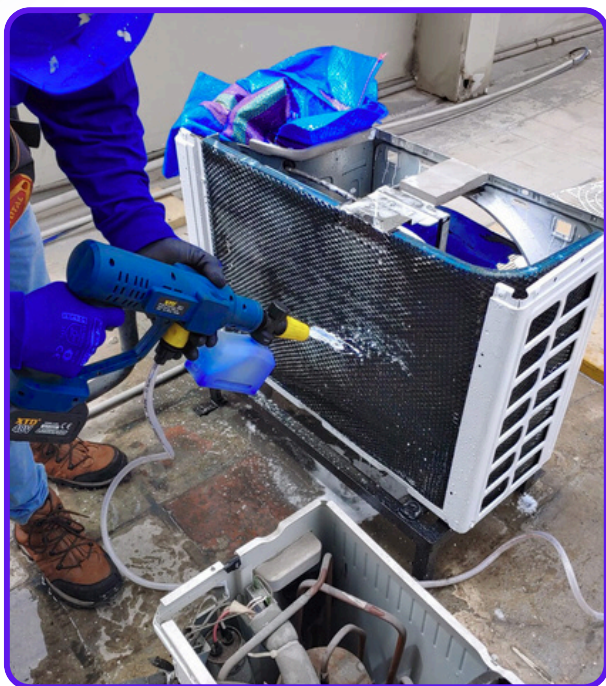
Mantenimiento Preventivo de Aire Acondicionado
