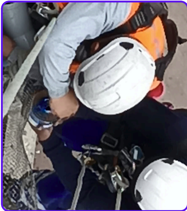
Reparación de Tubería Montante de Desagüe
