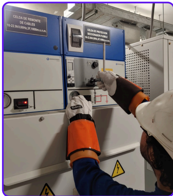
Mantenimiento de subestación de Media Tensión
