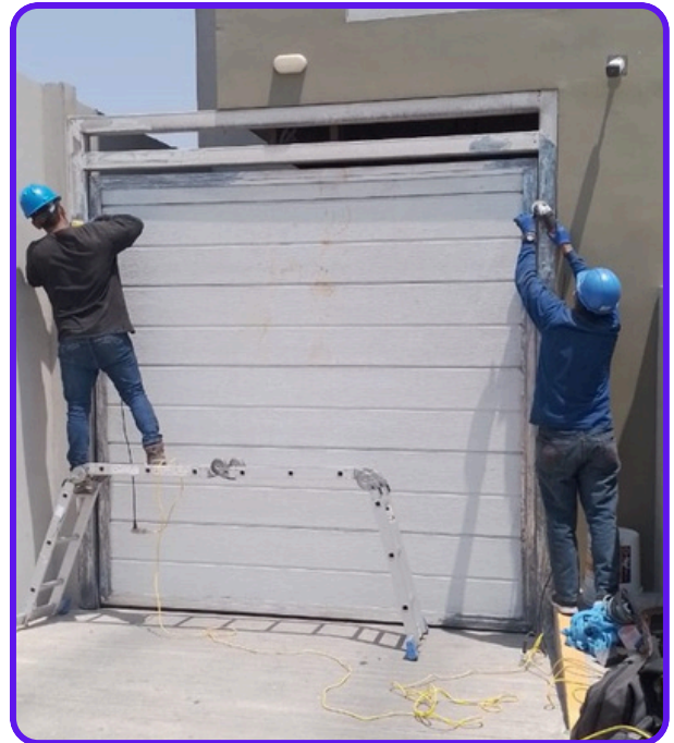
Pintado de Puerta de Acceso Vehicular
