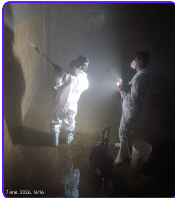
Limpieza de Cisterna
