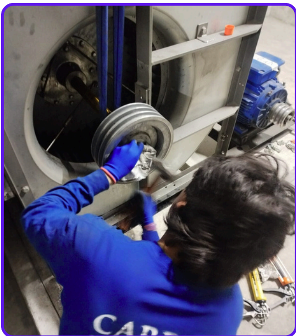
Mantenimiento Correctivo de Extractores de Monóxido
